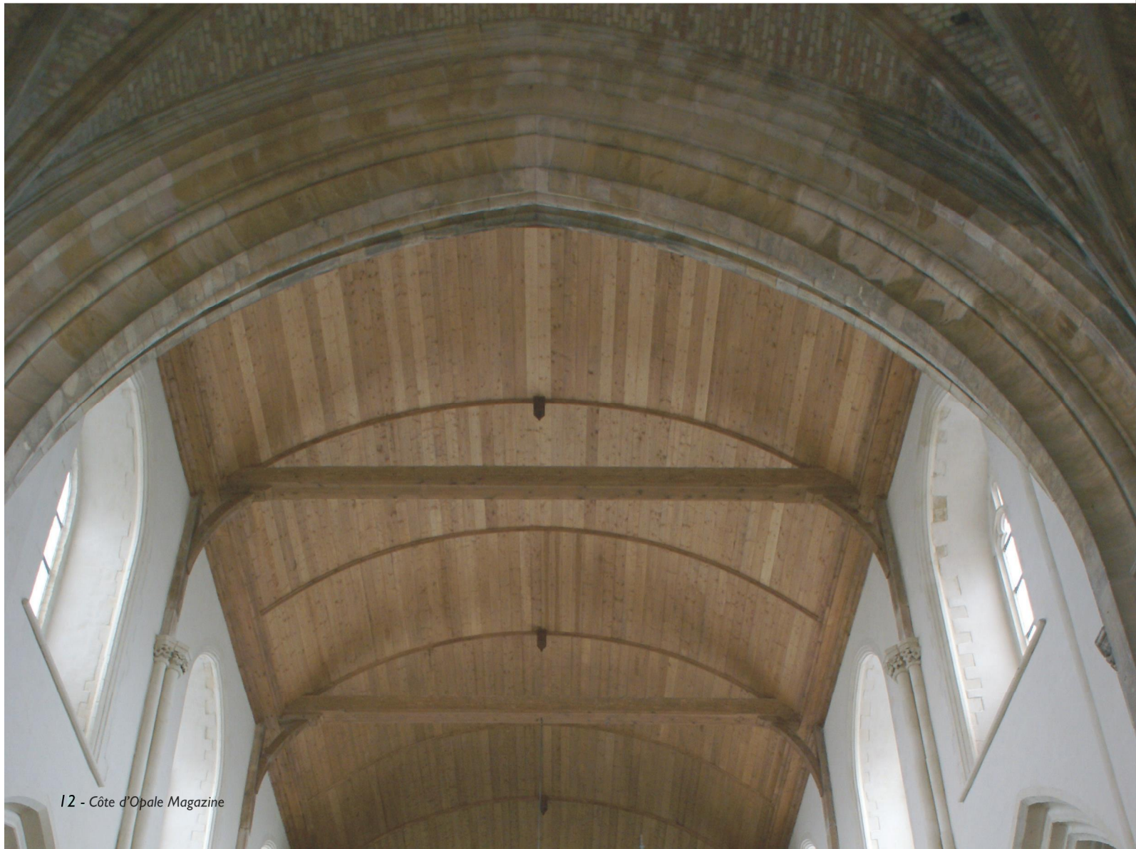
CI-DESSOUS : UNE AUTRE VOÛTE APORTE SA NOTE CHALEUREUSE. À DROITE : LE DESSOUS DU CLOCHER (EN COURS EN RÉFÉCTION).
