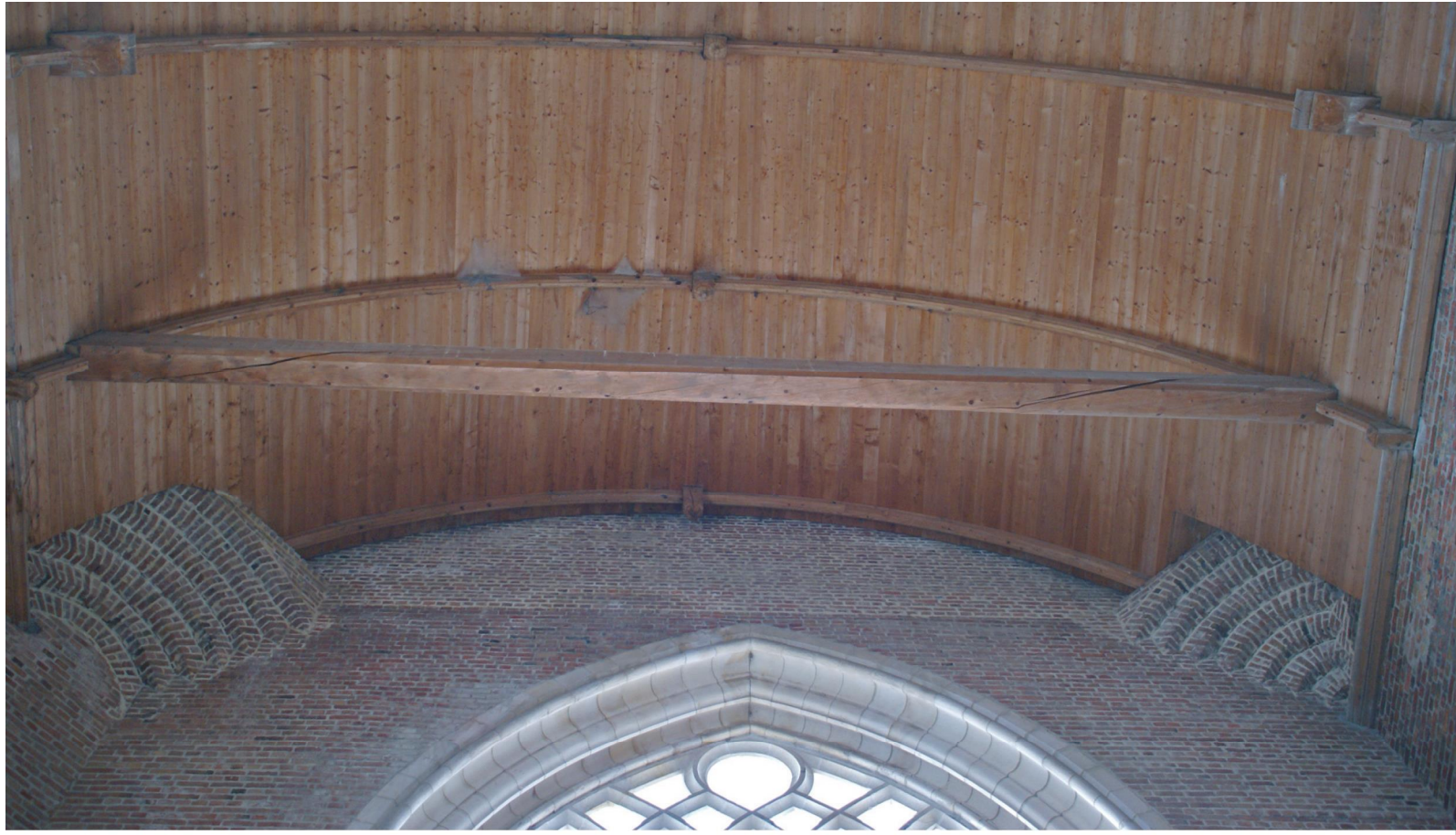
CI-DESSUS : VOÛTE DU TRANSEPT SAINT-PIERRE
