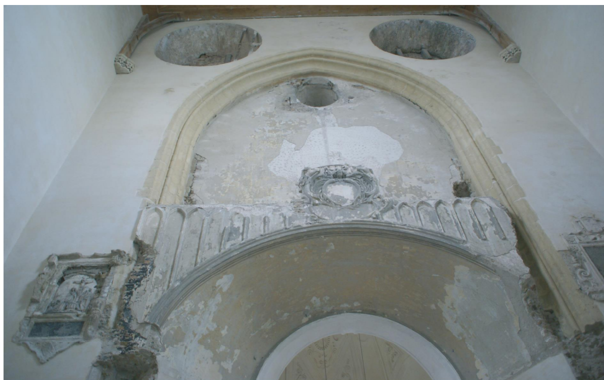
CHEVET ANGLAIS. EN COURS DE RÉNOVATION.
